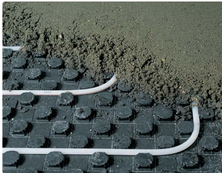
Свойства цементных дстяжек в соотв. с DIN 18560 могут быть улучшены специальными добавками Uronor
