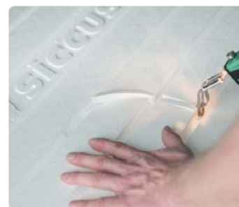
Дополнительные каналы могут быть выпилены электроинструментом
