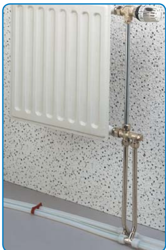
Снизу, с помощью медных никелированных тройников Uponor Q&E
