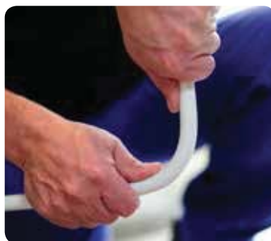
Сгибание трубы Uni Pipe Plus
