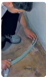
Установка демпферной ленты Upronor Minitec
